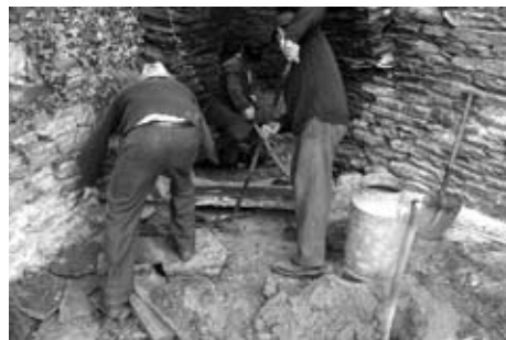
Colocación da lastra na entrada da boqueira
