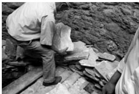
Inicio do paredado interno
